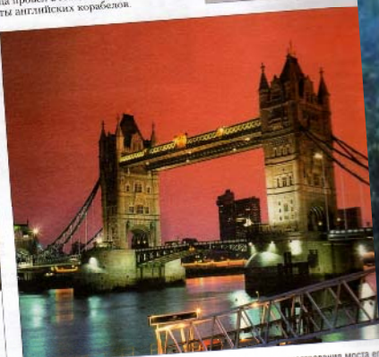
Тауэрский мост был возведен в 1895 г. В первый месяц существования моста ему приходилось разводиться по 30–40 раз в день. А чтобы пешеходы не страдали, были предусмотрены мостики между двумя башнями, на которые можно было подняться на
